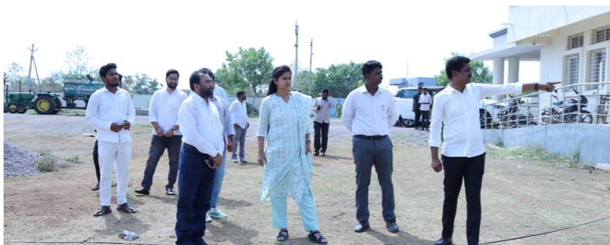
నింటర్ (డి.వి.ఎస్) కోసం ప్రతిపాదించిన స్థలాన్ని పరిశీలించారు. అనంతరం నిర్మాణంలో ఉన్న డామెర చెరువు కట్ట బండ్, నాలా, కాలువ అభివృద్ధి పనులను మున్సిపల్ చైర్మన్, అధికారులతో కలిసి పరిశీలించి పనుల పురోగతిని సమీక్షించారు.
